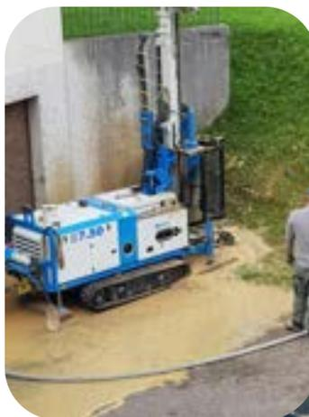
Travaux de forage dans le cadre de l'installation du système d'aquathermie
