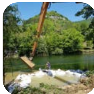
Réparation de la conduite du surpresseur passant sous la Loue
