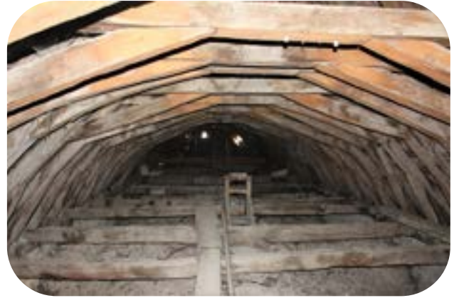
Impressionnant poutrage d'origine en forme de vaisseau inversé
