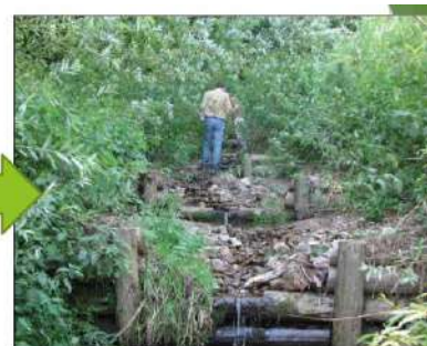
Mise en place d'ouvrages bois et blocs pour limiter l'incision, remonter le fond du lit et créer des habitats pour la faune aquatique
