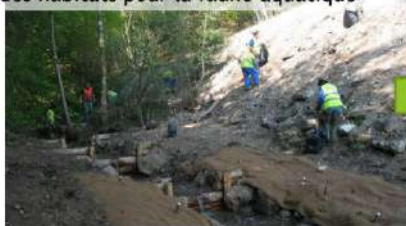
Mise en place d'ouvrages bois et blocs pour limiter l'incision, remonter le fond du lit et créer des habitats pour la faune aquatique
