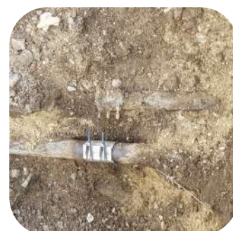
Réparation d'une conduite
