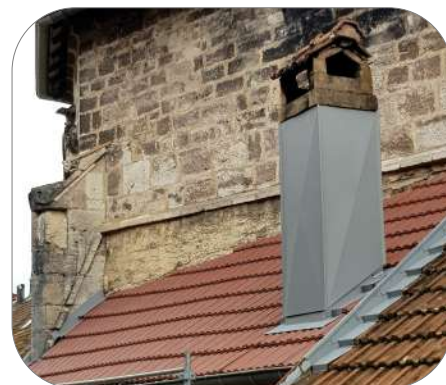
Un toit tout neuf pour la chaufferie de l'église - Effectué par Morgane Dole.
